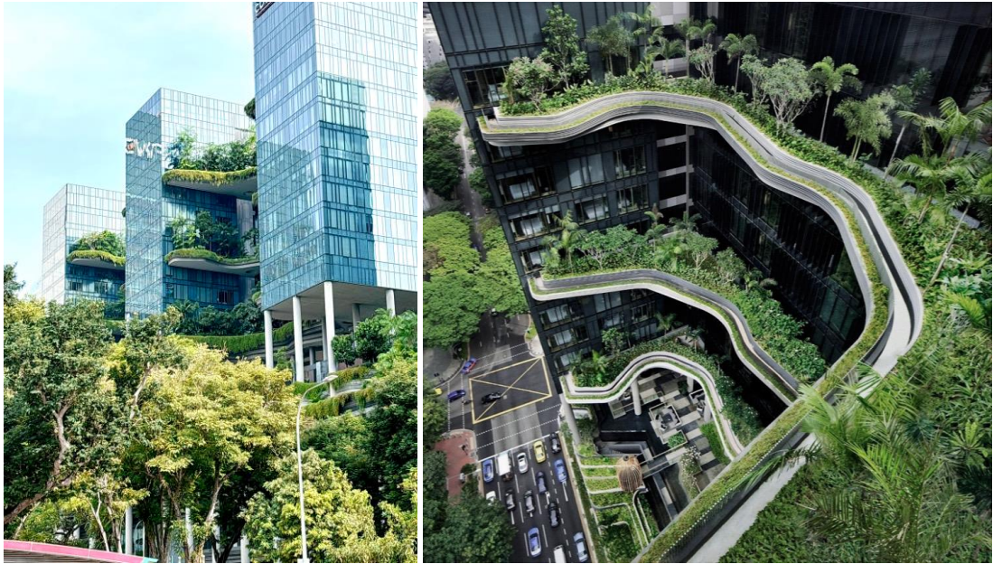
圖 34 皮克林賓樂雅酒店每四層設置一處露臺花園
