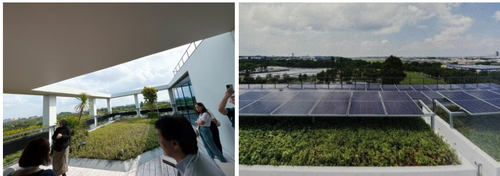
圖 24 The GEAR 於屋頂及露臺裝設太陽能光電系統
