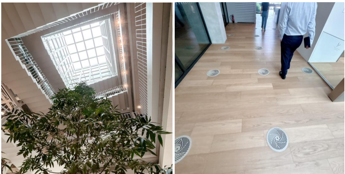
圖 21 左為 The GEAR 室內之中庭(浮力)通風，右為空調下出風口之設置
