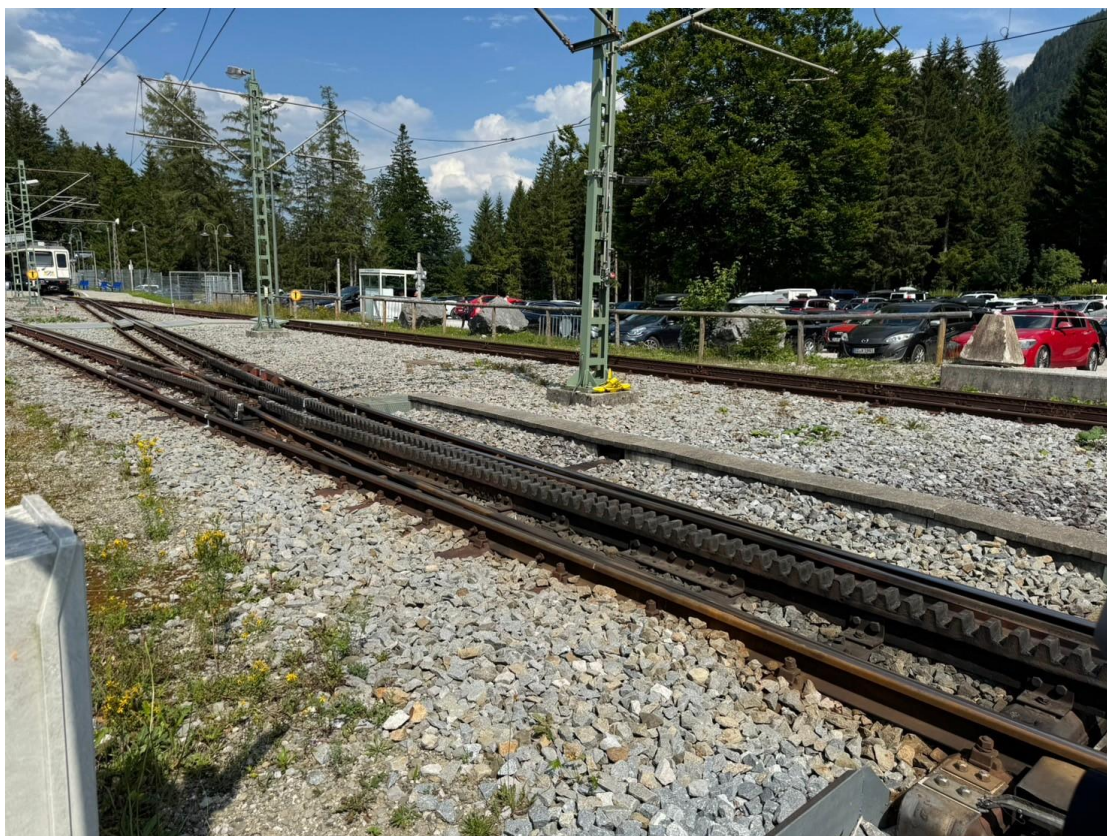
圖 2.3-4 齒軌鐵路結構
