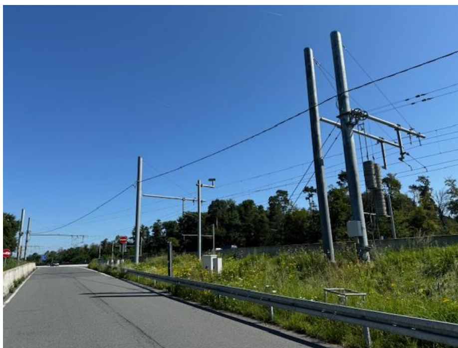
圖 2.2-5 eHighway 於公路上設施配置情形
