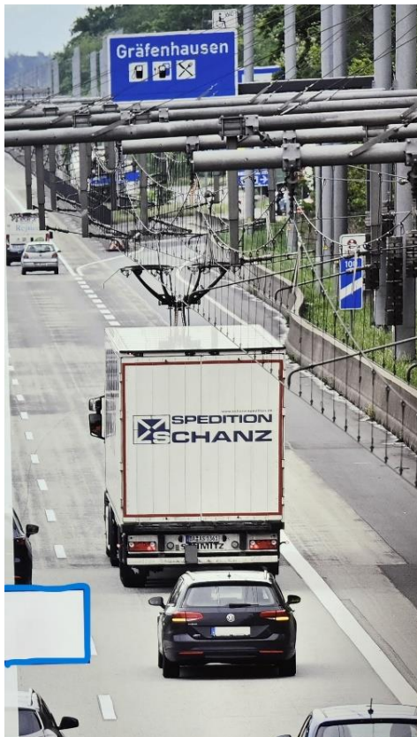
圖 2.2-7 具集電弓卡車行駛在 eHighway(與一般汽車共用車道)
