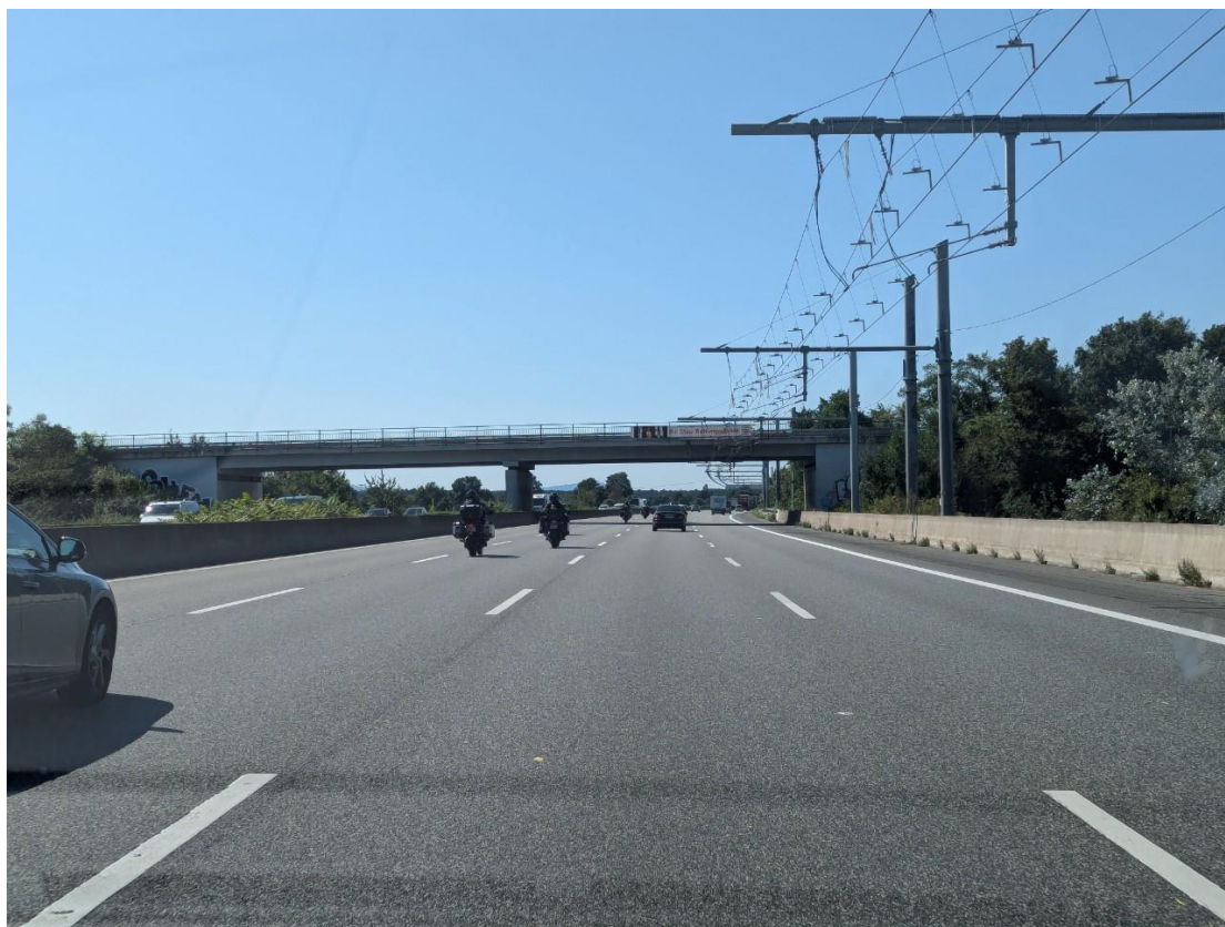
圖 2.2-4 eHighway 於公路上設施配置情形
