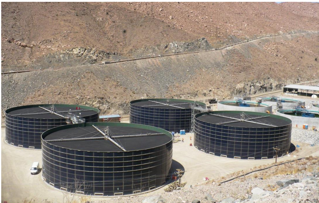
La Enlozada 廢水處理廠處理池
