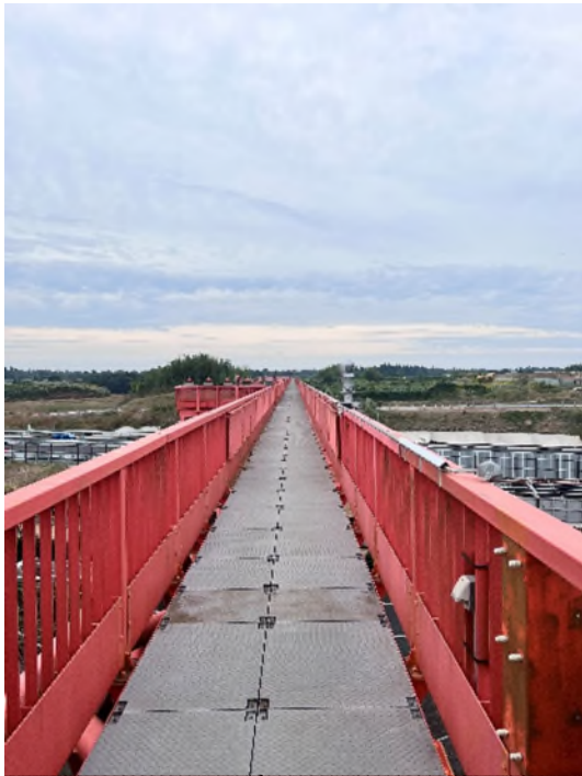
既有16L 進場燈光橋
