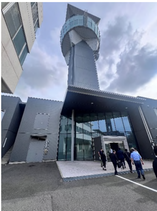
本次參訪地面塔台
