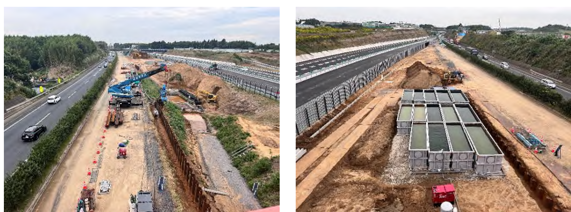
既有高速公路（東關東自動車道）改道工程
