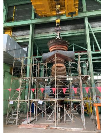
圖十、舊式的安裝轉子及動葉直立式施工架
