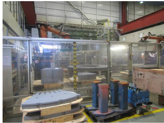
圖四十一、發電機矽鋼片堆疊區
