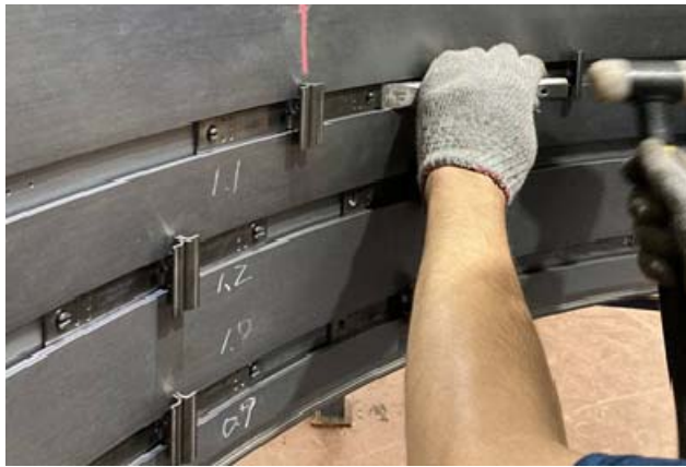
圖五、確保支撐架夾頭呈現最小間隙
