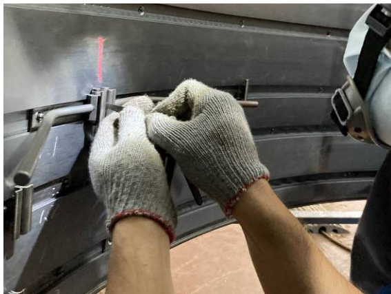
圖七、用厚薄規確認耐火磚支撐架夾頭間隙
