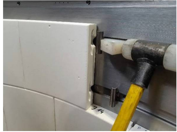
圖十六、使用裝配楔治具將耐火磚支撐架 插入耐火磚脊上極限位置
