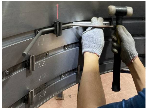
圖六、用提升桿將耐火磚支撐架夾頭旋轉頂起
