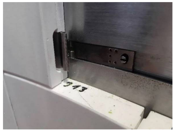
圖十二、定位銷旋入90~270°並調整一字頭為水平
