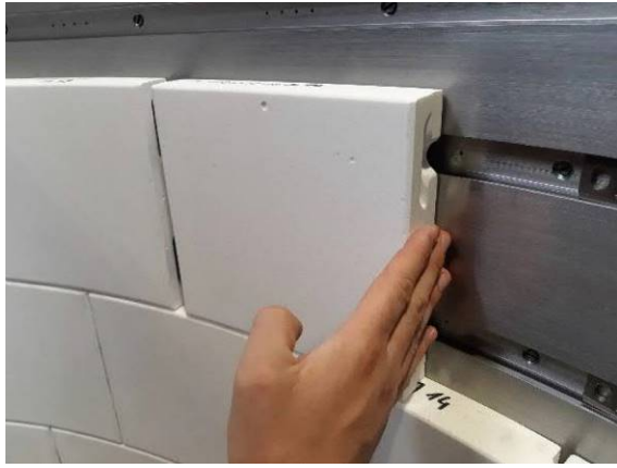
圖十五、將耐火磚放入耐火磚支撐架中
