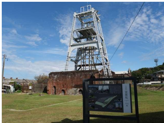
第二豎井豎坑櫓及水泵房未拆除牆面
