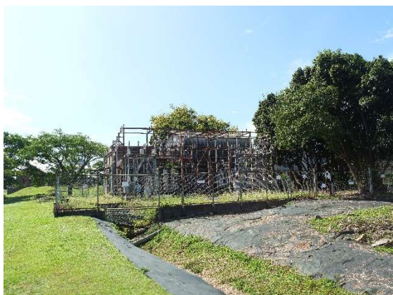
宮原坑變電所遺址
