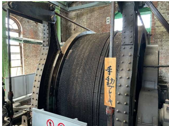
捲揚機室内部鋼索捲筒
