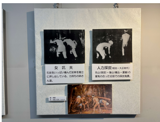
坑內作業照片
