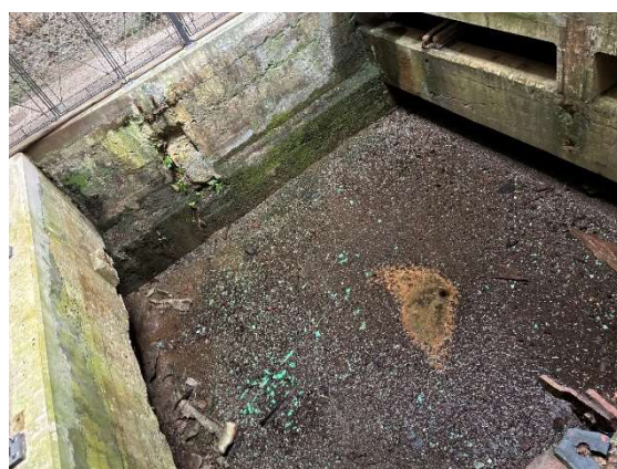
二號豎井坑口以混凝土填平
