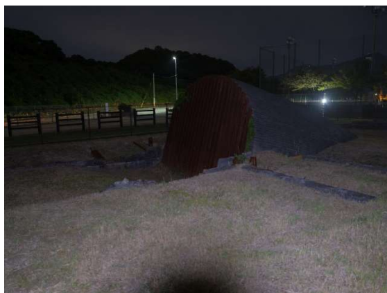
第八斜坑現況
