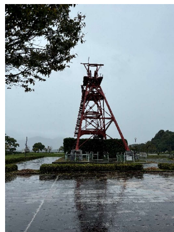
伊田坑豎坑槽
