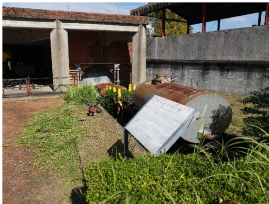
材料降下坑口跡
