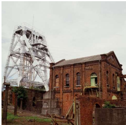
二號豎坑櫓及捲揚機室
