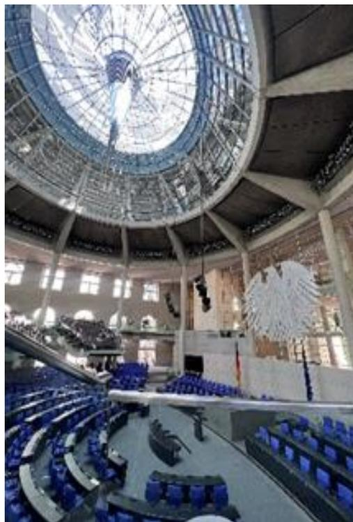
德國國內自反核興起對於生態理念的公民運動，70 年代的環境運動中強調生態重要性應先於經濟發展，因此在重新設計時被要求整體建築需考慮能源使用效率及以綠建築為改造目標。玻璃穹頂位於大廈上方，除了回應過去歐洲建築風格外，並兼具採光、供暖及取能的功用，要求要自然採光及通風，並且需使用自然的熱能，成為國會會議廳白天主要的照明來源；於議場內的通風設備與遮陽設備，透過屋頂上的太陽能板產生的電力運作，透過冷熱空氣交換，維持室內舒適度以及降低通風設備產生的耗能及噪音。
