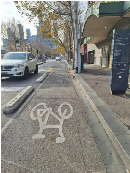
圖 34 自行車道透過緣石阻隔
