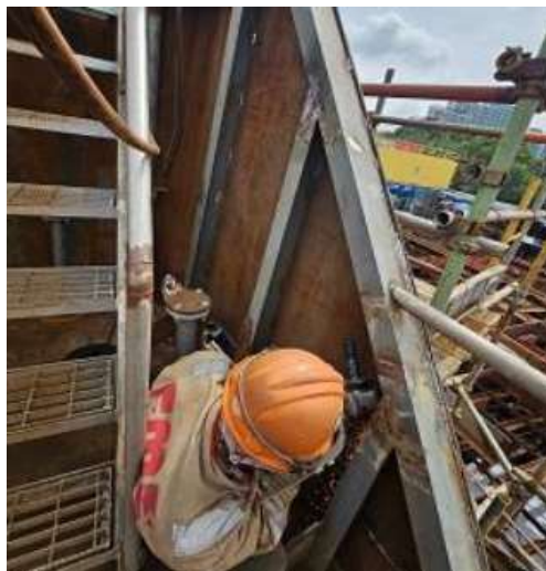
舷牆加強材施工
