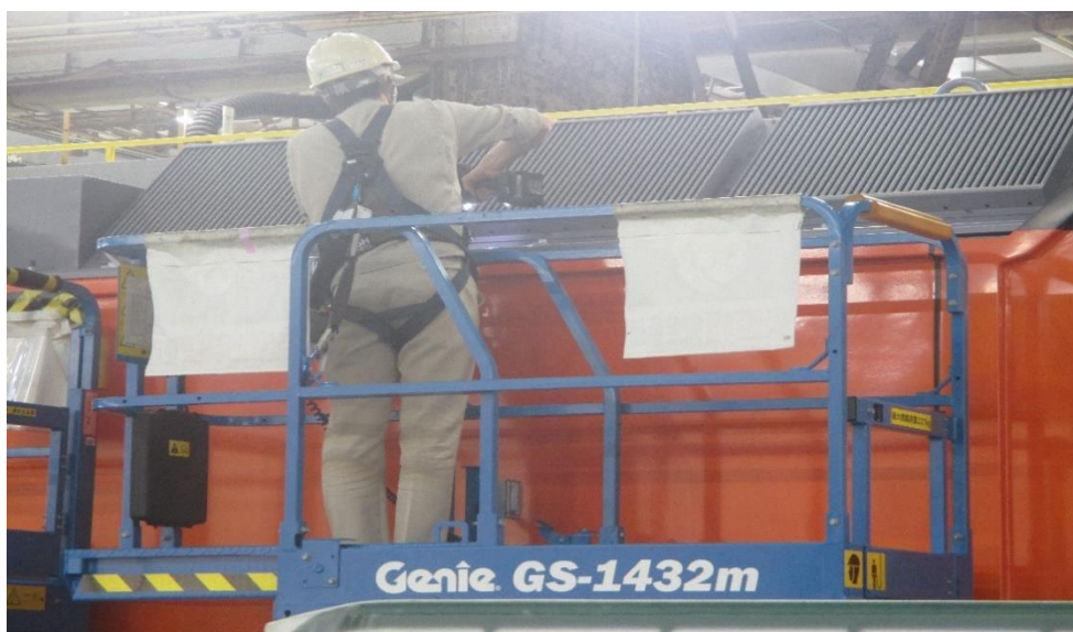
圖 5-2 電動扳手緊固屋頂螺栓
