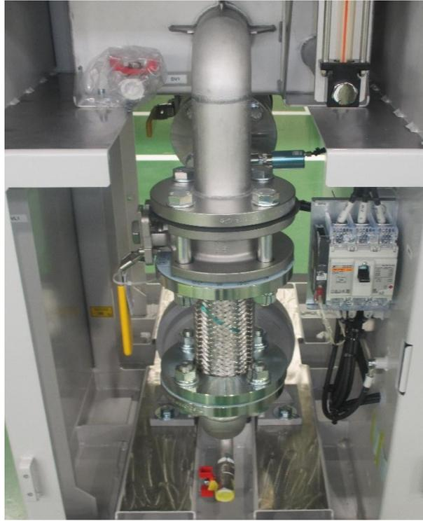
圖 5-4 E500 電力轉換裝置水冷泵浦
