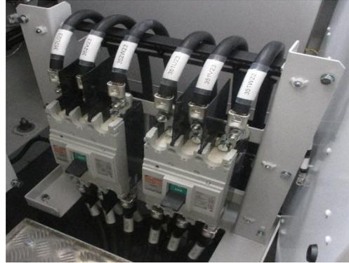
圖 3-1-7 輔助供電斷路器
