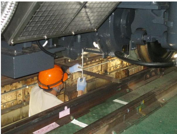
圖 3-3-11 量測車下設備 4
