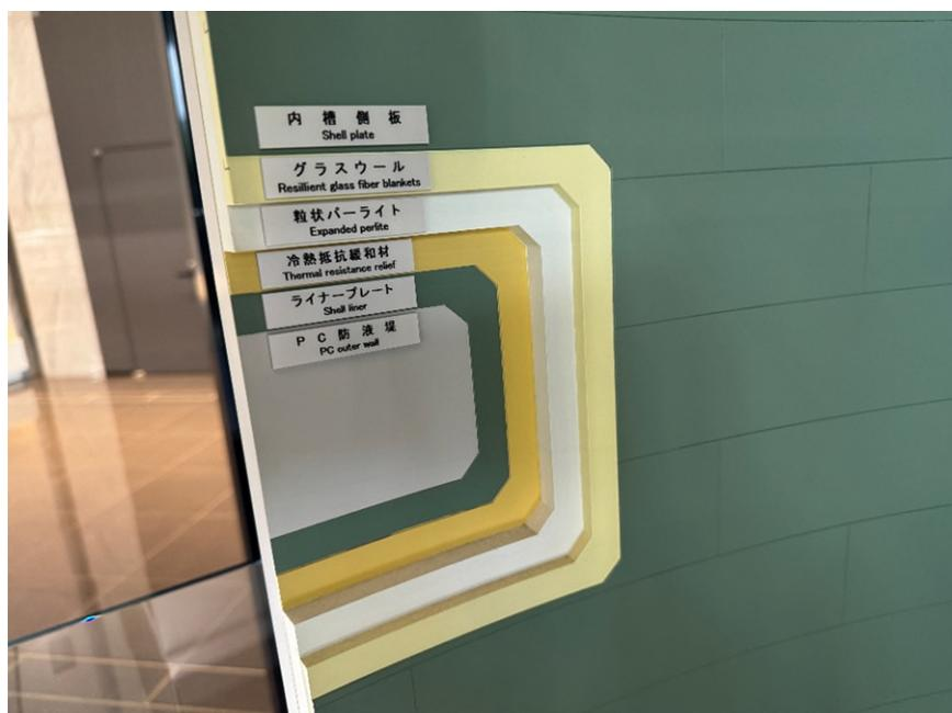
圖 4. 內外壁板與保冷材料
