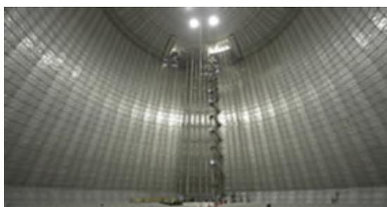
圖 1. 250,000m<sup>3</sup>地下式儲槽(膜結構)
