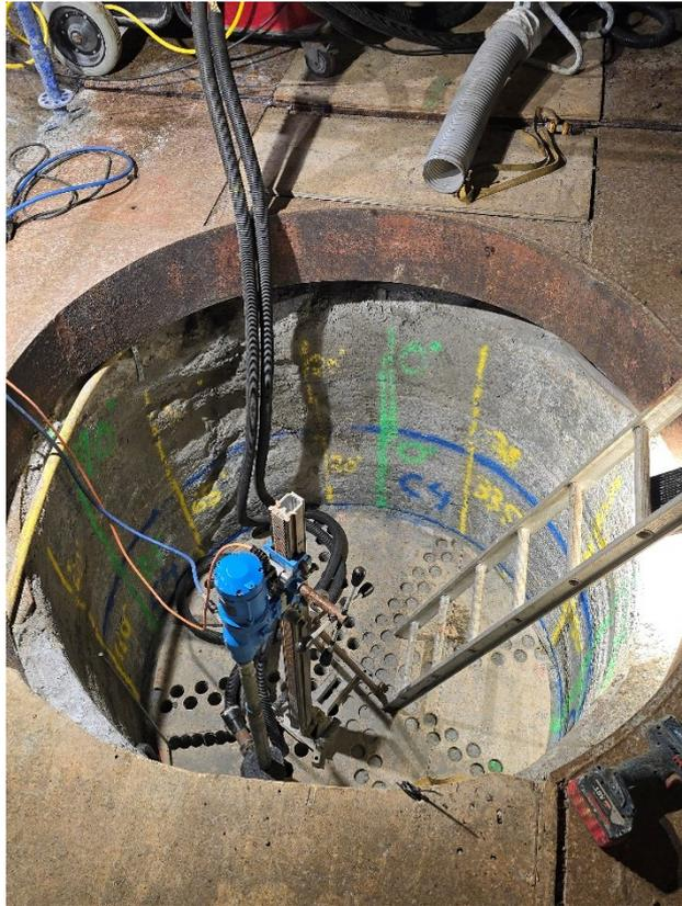
圖 45：全尺寸取樣計畫開挖之處置孔
