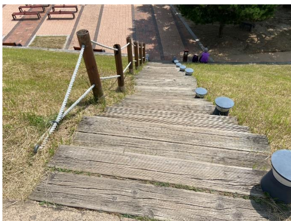
圖 22 步道欄桿採用麻繩及木條組成
