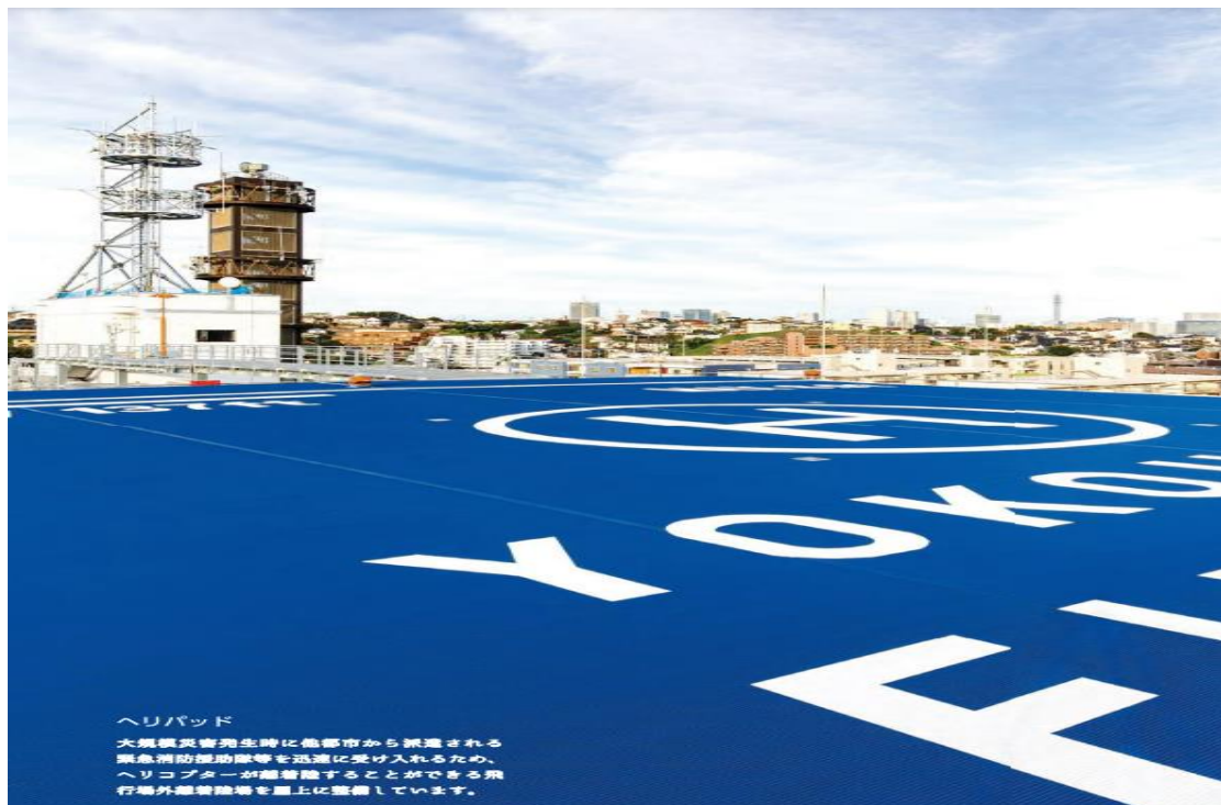
圖 52 橫濱市消防局消防勤務直升機專用停機坪
