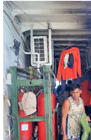
▲全船備有中央空調設備
