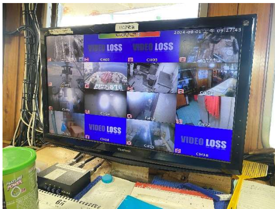
▲檢視 CCTV 錄影畫面
