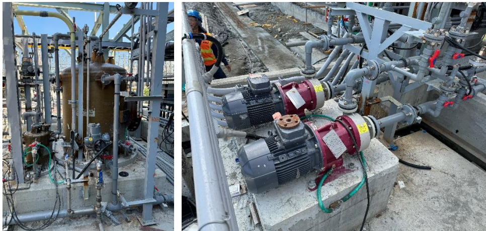
圖 22 酸煙去除裝置、8%稀鹽酸/洗滌劑儲槽(左圖)及酸/洗滌劑循環泵(右圖)
