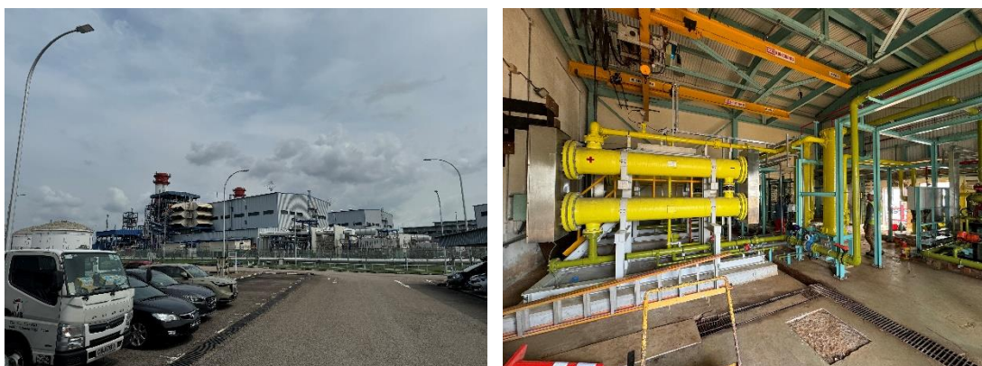
圖 4 西拉雅發電廠(左圖)及其海水電解設備(右圖)
