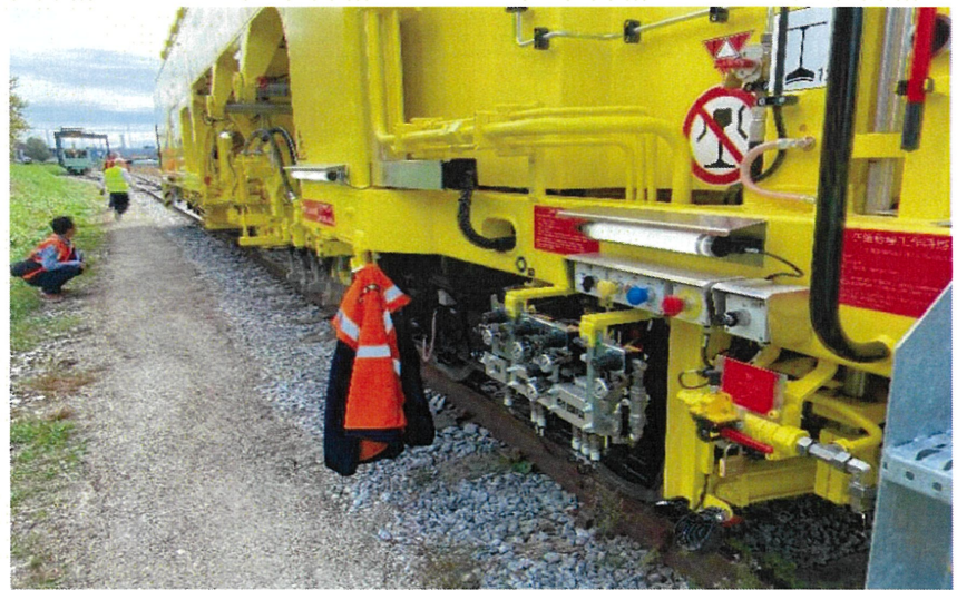
圖 41 大型砸道車手動控制砸道機構、作業區域燈號
