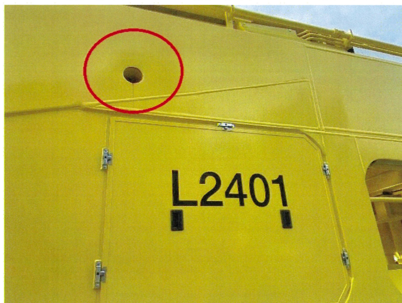
圖 26 大型砸道車吊掛點
