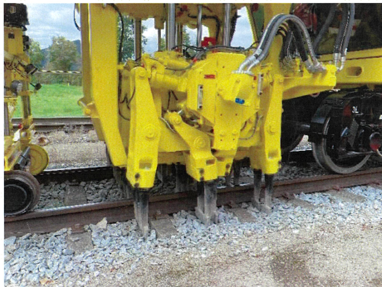
圖 52 大型砸道車砸道作業一次砸道 2 根軌枕測試
