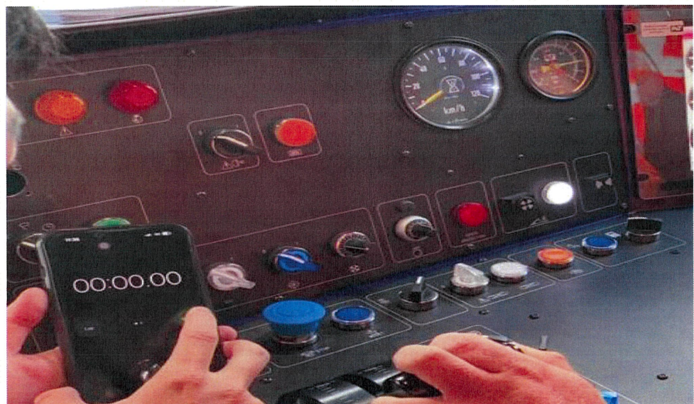
圖 47 大型砸道車未按警醒裝置鈕測試
