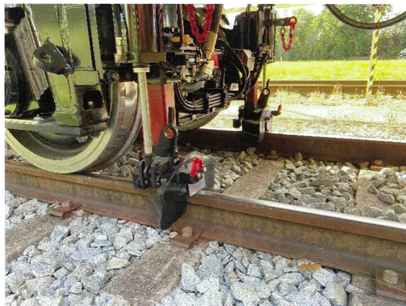
圖 23 大型砸道車除碴裝置
