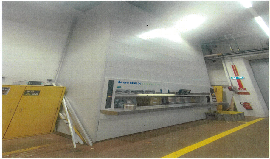
圖 126 油漆存放設備
