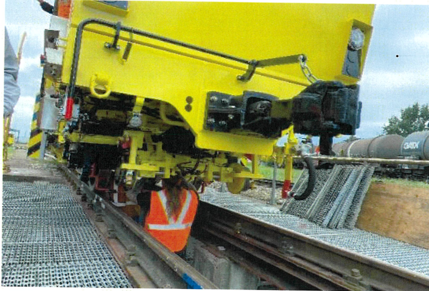
圖 106 軌道穩定車車輛通過縮小車輛界限框測試
