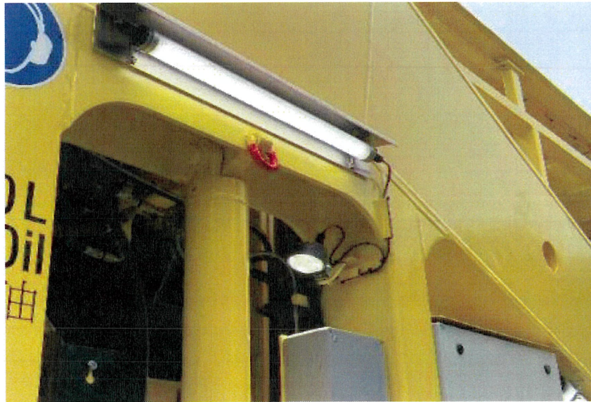
圖 76 中型砸道車手動控制砸道機構、作業區域燈號
