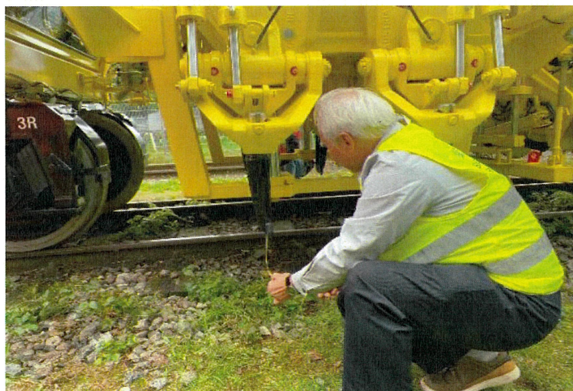
圖 87 中型砸道車砸道作業一次砸道 1 根軌枕測試
