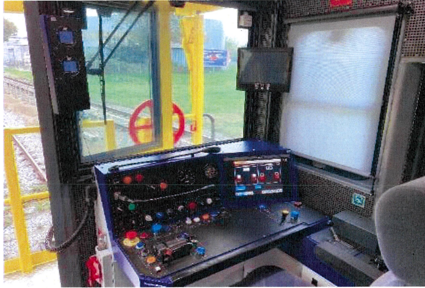
圖 80 中型砸道車確認操作聯掛測試(操作連鎖測試)
