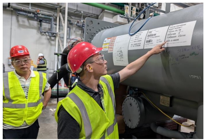
說明：1050RT 冰機測試過程確認
