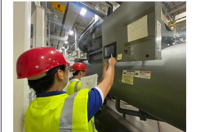
說明：1300RT 冰機測試過程確認
