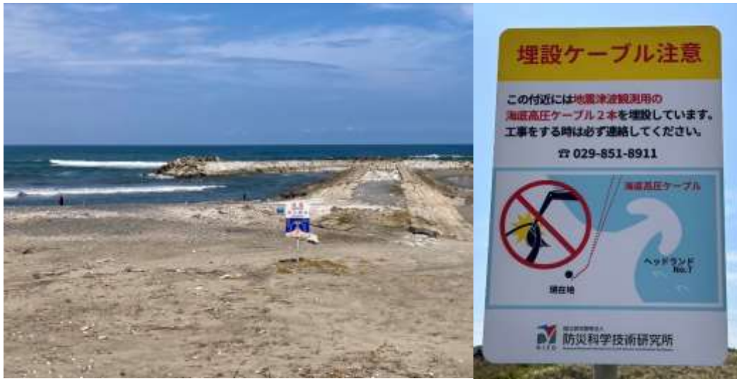
圖 14、防災科學技術研究所(NIED)S-net 陸上站海纜登陸點：左圖係海灘 T 型突堤(突堤建置晚於海纜登陸)、右圖係禁止開挖告示牌(紅色虛線係海纜路線、提醒該處禁止開挖)。
