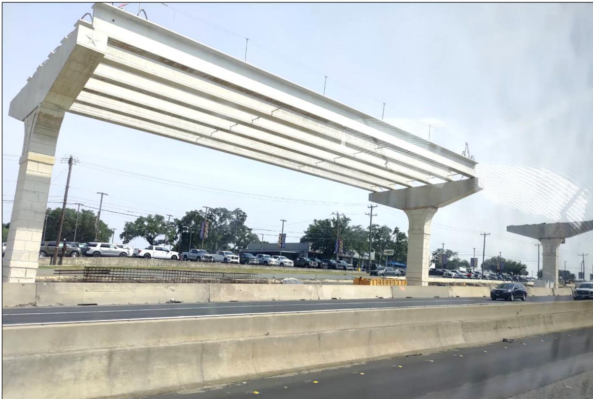
圖 63、35 號州際公路進行之高架橋工程
