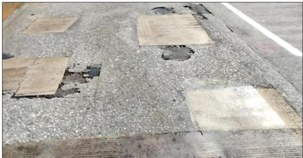
圖 17、Delaware Memorial Bridge 橋面劣化修補情形
