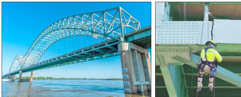
圖 45、Hernando De Soto Bridge 及主跨鋼梁斷裂情形
