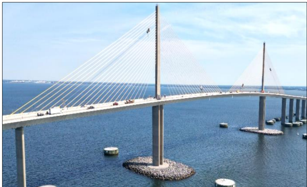
圖 21、Sunshine Skyway Bridge 主跨照片
