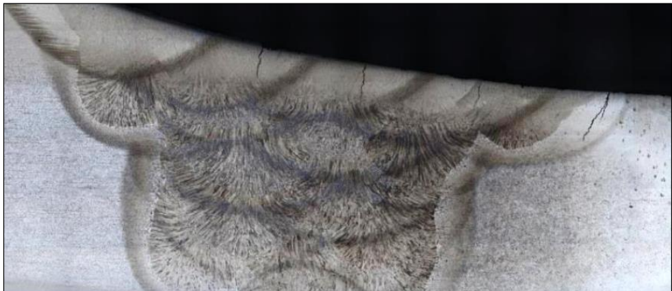
圖 47、現場樣本於焊道頂部觀察到之裂縫
