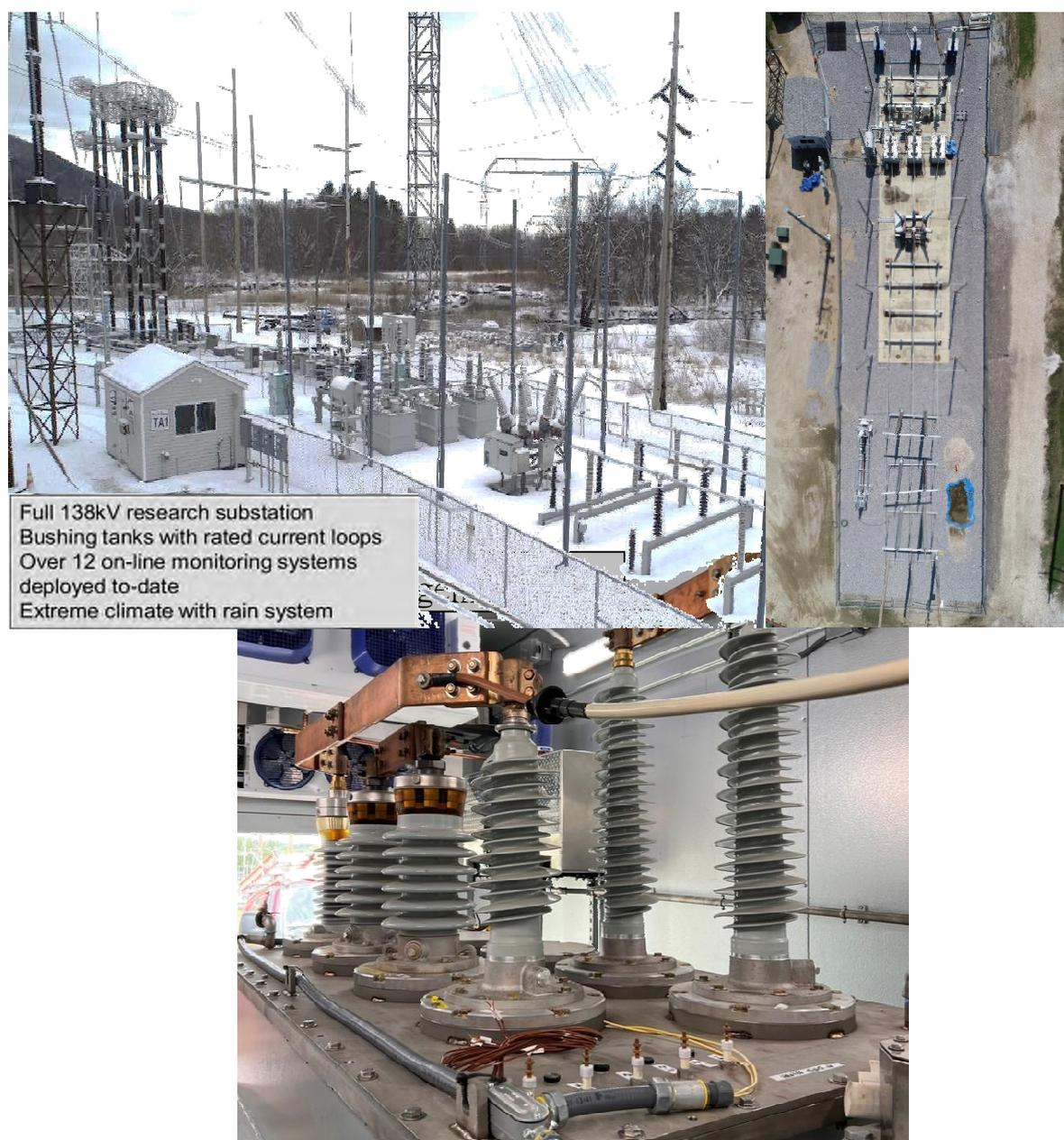
圖 4.4 MA.Lenox,138 kV 變電站極寒試驗場(EPRI 夏洛特研究中心)
