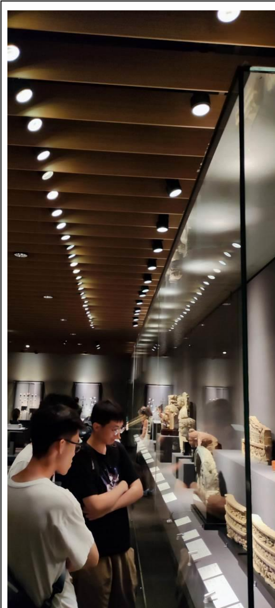
東洋館主要使用的照明系統包括天花板的投射燈搭配展櫃頂霧面玻璃。
