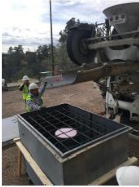
圖 2 安全就地存放 (Secure In-Place Storage, SIPS)
