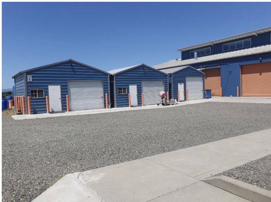
圖 66 室外水泥混凝土試鋪
