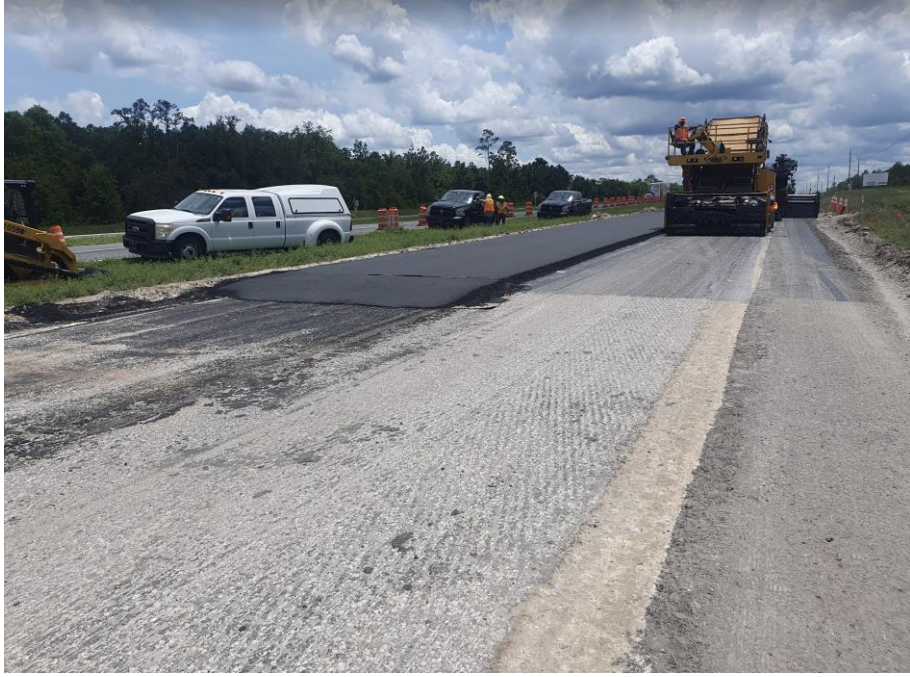
圖 52 筆者前往 SMO 柔性路面試驗道路觀摩施工情形
