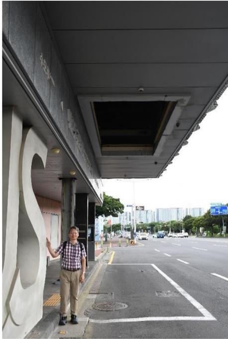
圖47 電池交換站上方裝置已拆除1
