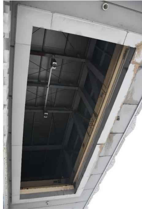
圖48 電池交換站上方裝置已拆除2
