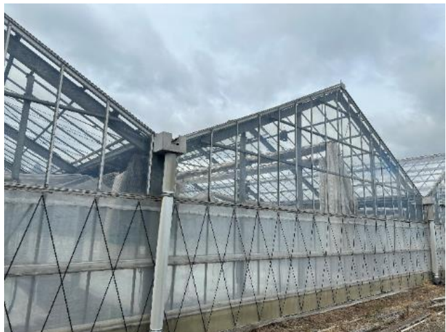
番茄玻璃鋼構溫室
