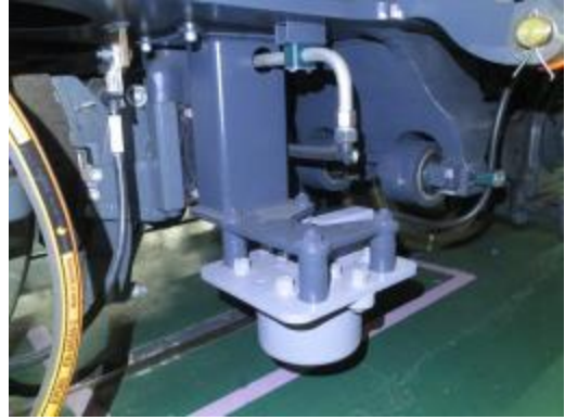
圖 6-8-6.APC 偵測器實際安裝情形
