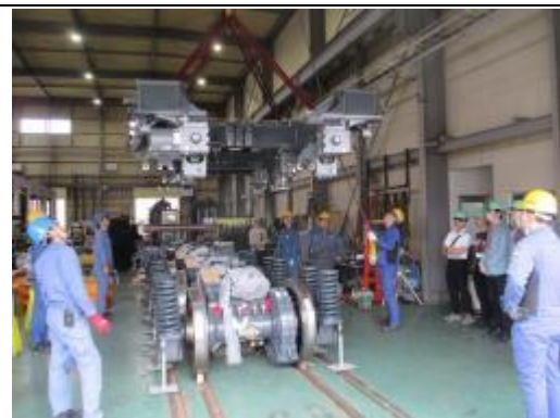
圖 6-1-7. 轉向架吊掛安裝
