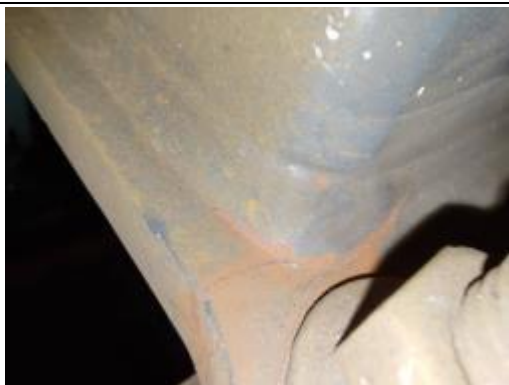
圖 6-8-7.APC 偵測器支架斷裂
