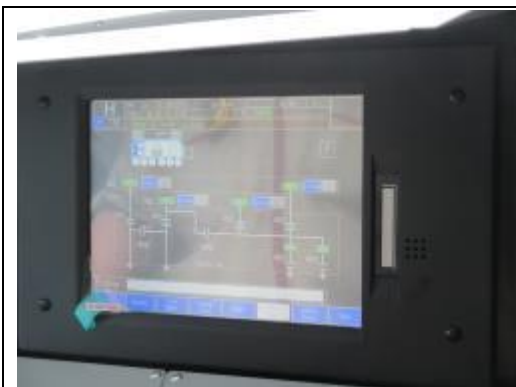
圖 1-3.APU/HEP 正常送電
