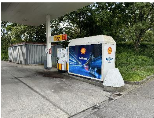
本站設置獨立之大車柴油泵島，該泵島亦設置 4,000 公升尿素水儲槽及尿素水機。
