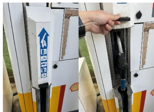
尿素水槍設有冬季保溫裝置，以避免尿素水產生結冰現象而無法加注。
