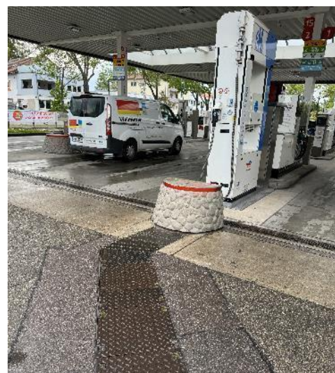
加氫輸送管線為地下管線，上方以鐵板覆蓋，以利後續維修及檢查。
