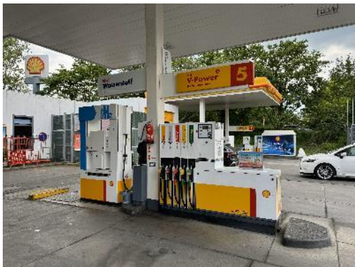
本站加氫機與加油機設置於同 1 座泵島。
