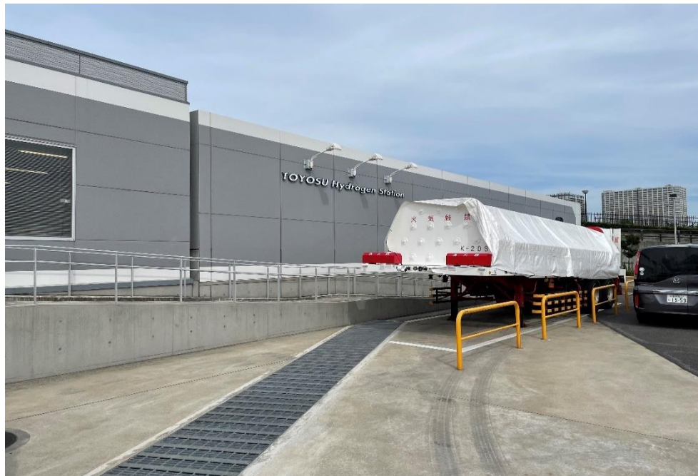
圖 7-7 東京瓦斯豐洲加氫站備用儲氫設備 資料來源：現場相片
