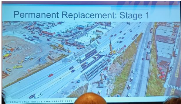
(11) 永久通行道路第一階段完成
