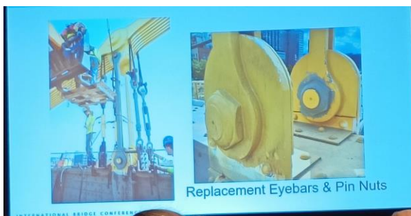
(7) 修復好鋼索接頭情形
