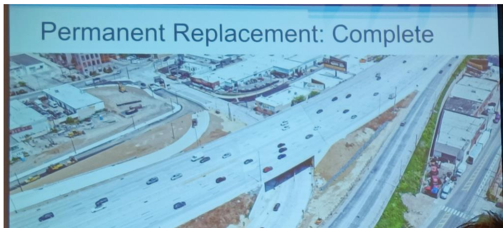
(13) 永久通行道路完成
