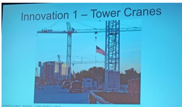
(7) 現地塔吊系統
