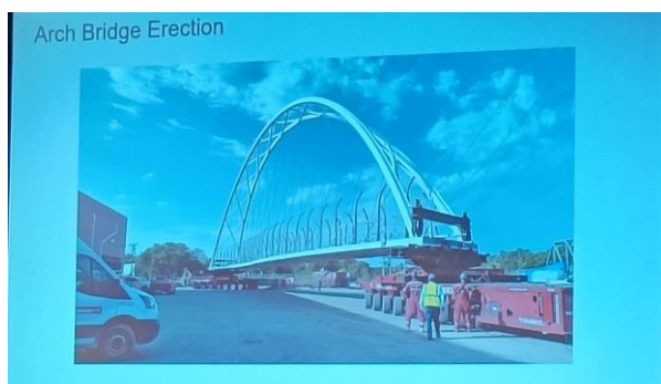
(5) 利用橋址附近空地先組立橋梁
