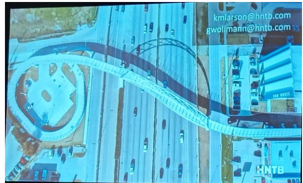
(8) 完成吊裝後之空拍
