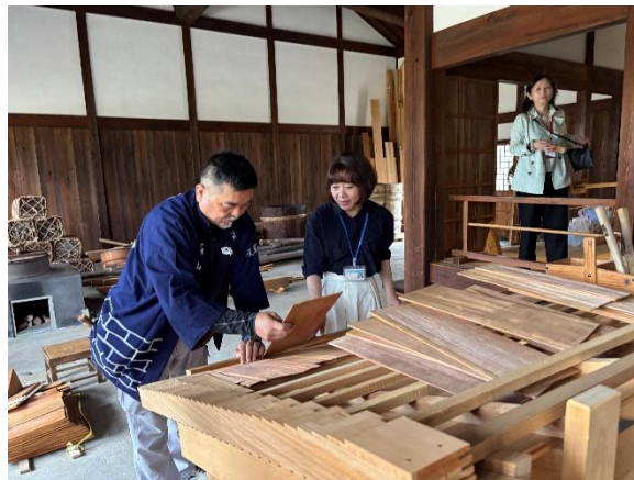
工匠師傅示範高山陣屋屋頂施作工法
