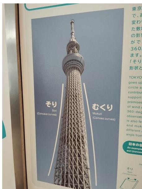
晴空塔整體輪廓帶入日本傳統建築的「そり」與「むくり」工法，形成柔和的曲線。
