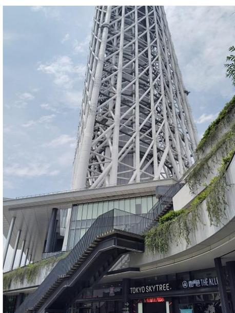
塔的內部是許多內部三角形構成的骨架結構，是為了確保超高層建築物安全性的設計。
