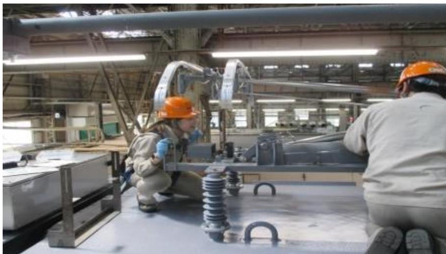
圖 3-10-3 最低工作高度壓力量測
