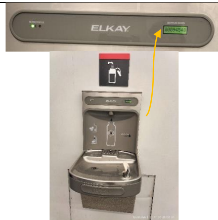
圖 14 校園內的自動飲水中，杯子放在出水口下方，即可自動給水，且會提供節省塑膠瓶數量。
