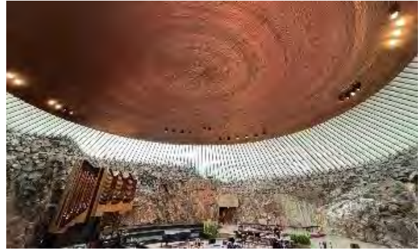
教堂銅製屋頂
