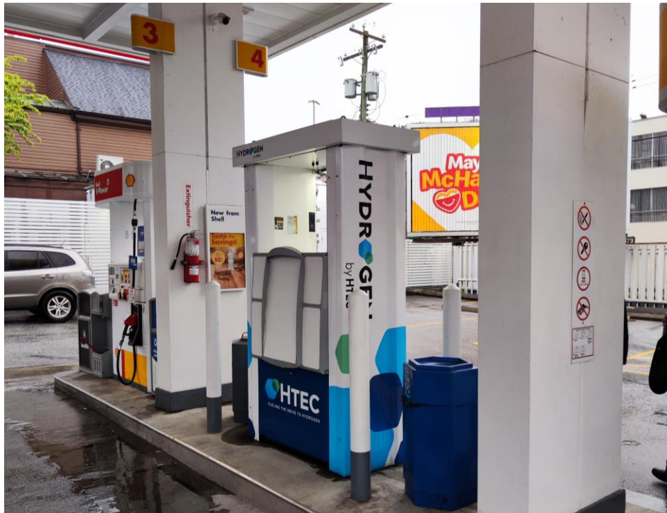
圖 33 加氫設備與加油設備的相對位置(近側為加氫設備)
