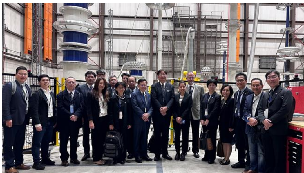
圖 27 Powertech 公司之高壓試驗設備
