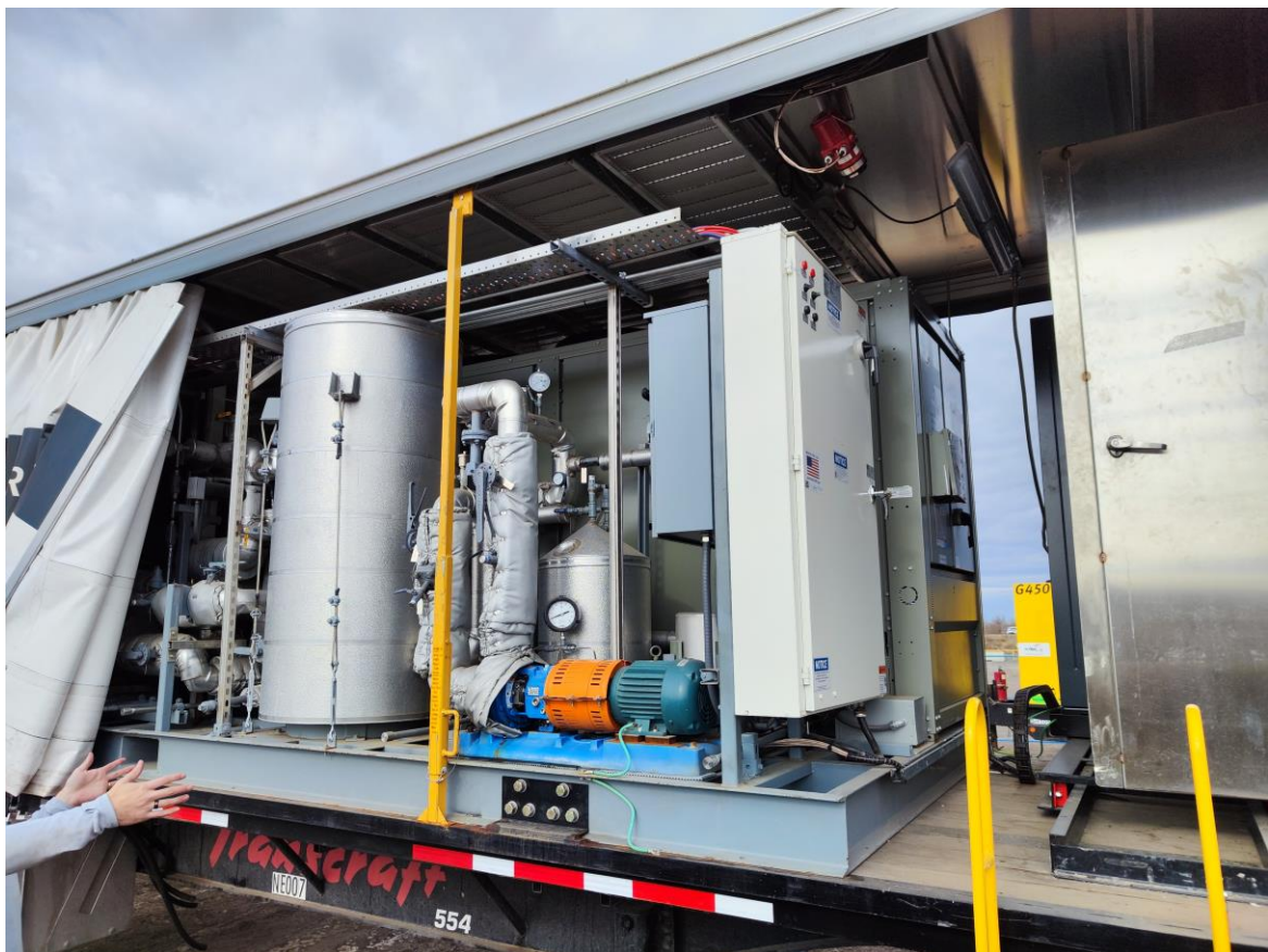
圖 16 Blackjack 加氫站氫氣加壓模組與控制盤
