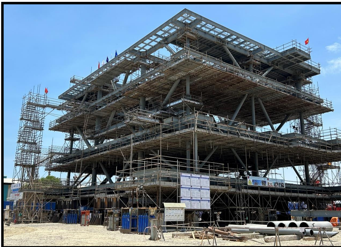
圖 29 海上變電站上部主結構已完成（第一至五層）
