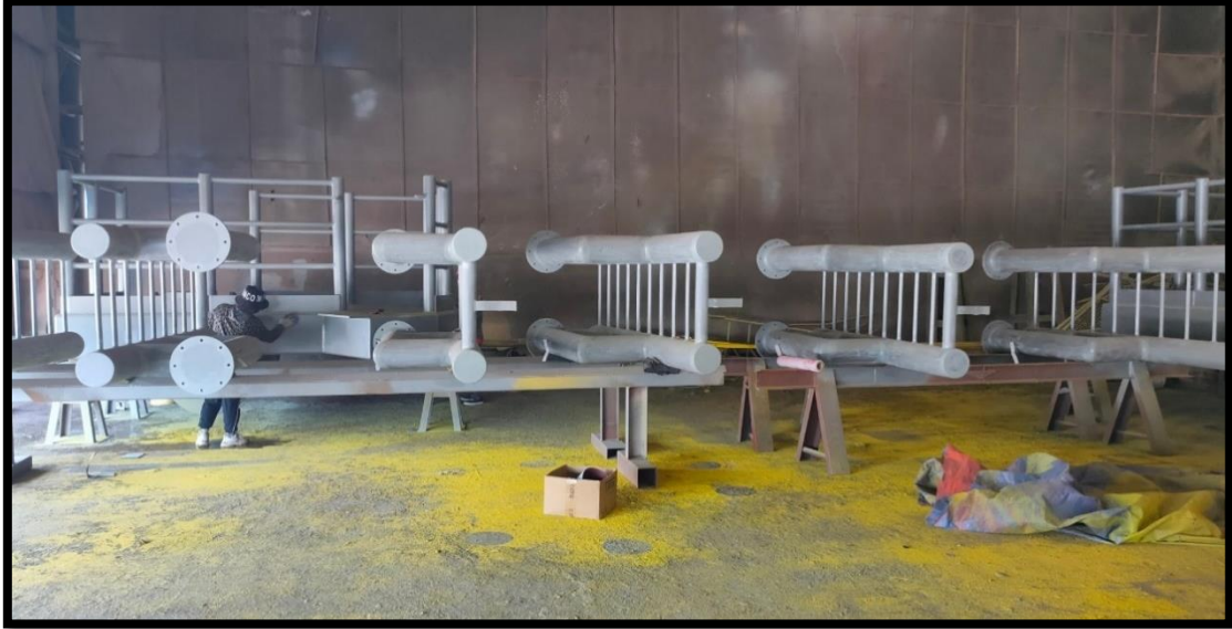
圖 12 外部爬梯、休息平台(防蝕塗裝作業中)
