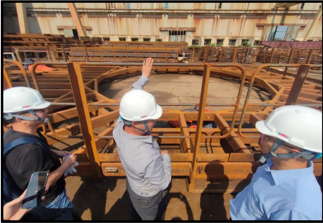
圖 8 外部平台(銲接組裝中)
