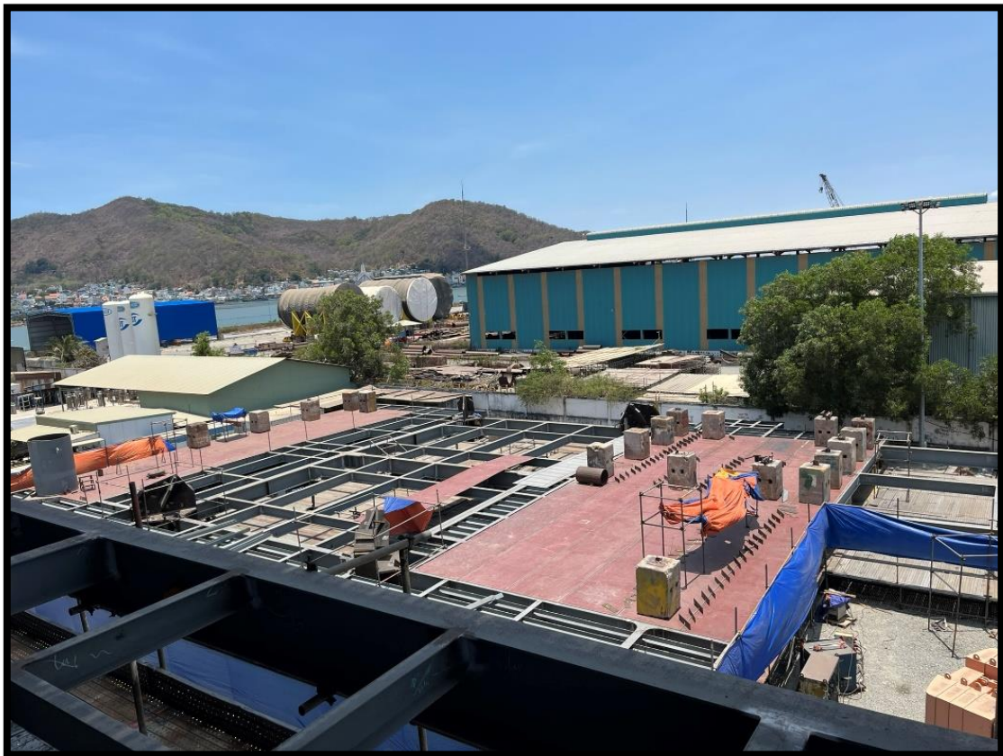
圖 32 ROOF DECK (第六層) 同步於地面預組立
