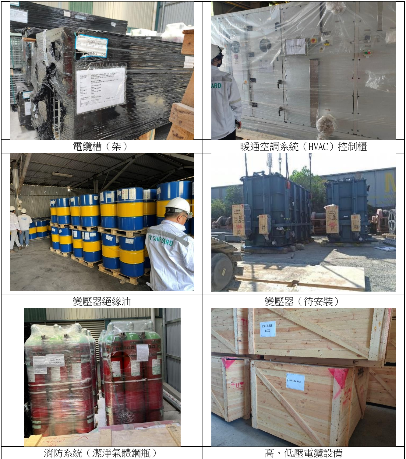
圖 33 已到貨之海上變電站機電設備
