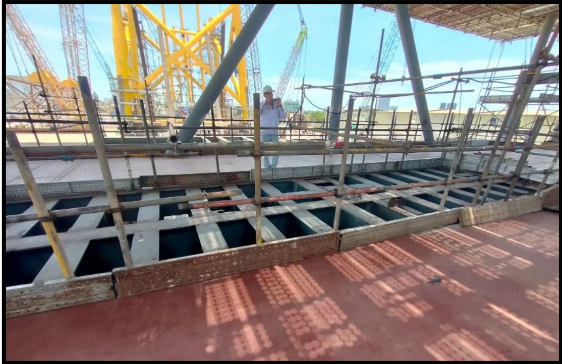
圖 31 MAIN DECK 161kV GIS 預留基座
