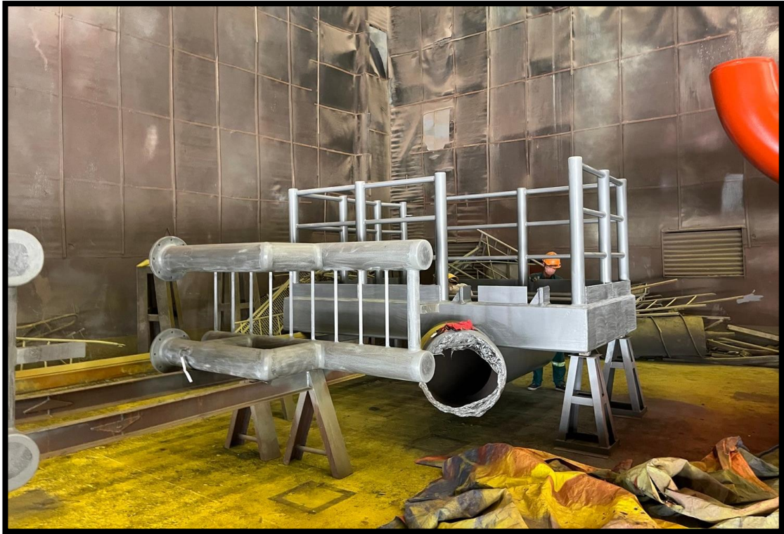
圖 14 中間平台(防蝕塗裝作業中)
