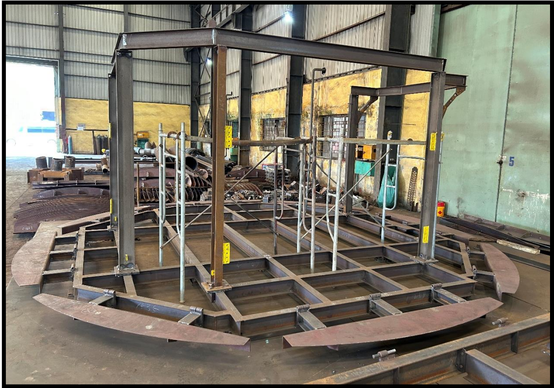
圖 10 內部平台(下層, 銲接組裝中)
