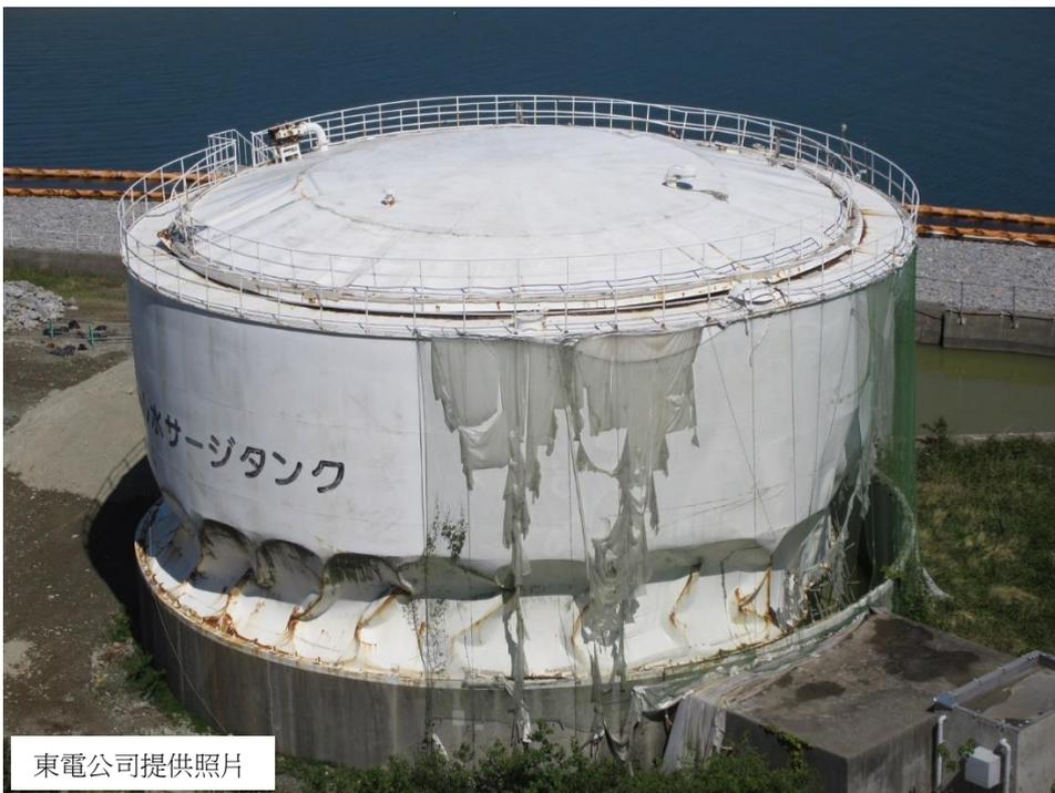
圖 39、岸邊所保留被海嘯破壞的桶槽
