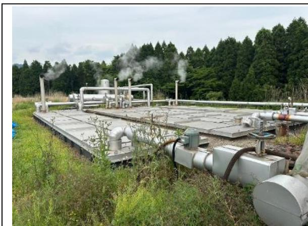
圖 4-9、利用溫泉蒸氣加熱溫室
