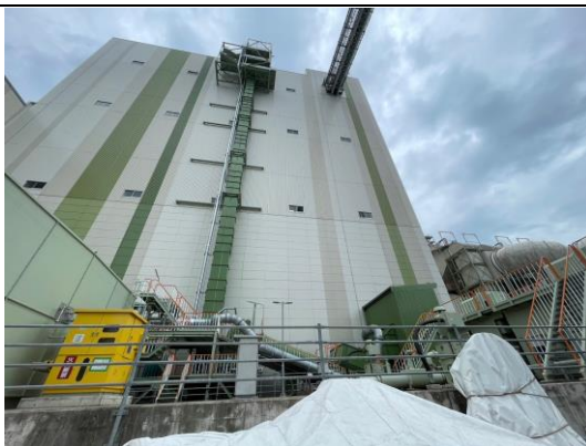
圖 3-6、竹原電廠木顆粒進料後輸送入廠內管道之情況
