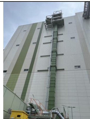
圖 3-6、竹原電廠木顆粒進料後輸送入廠內管道之情況
