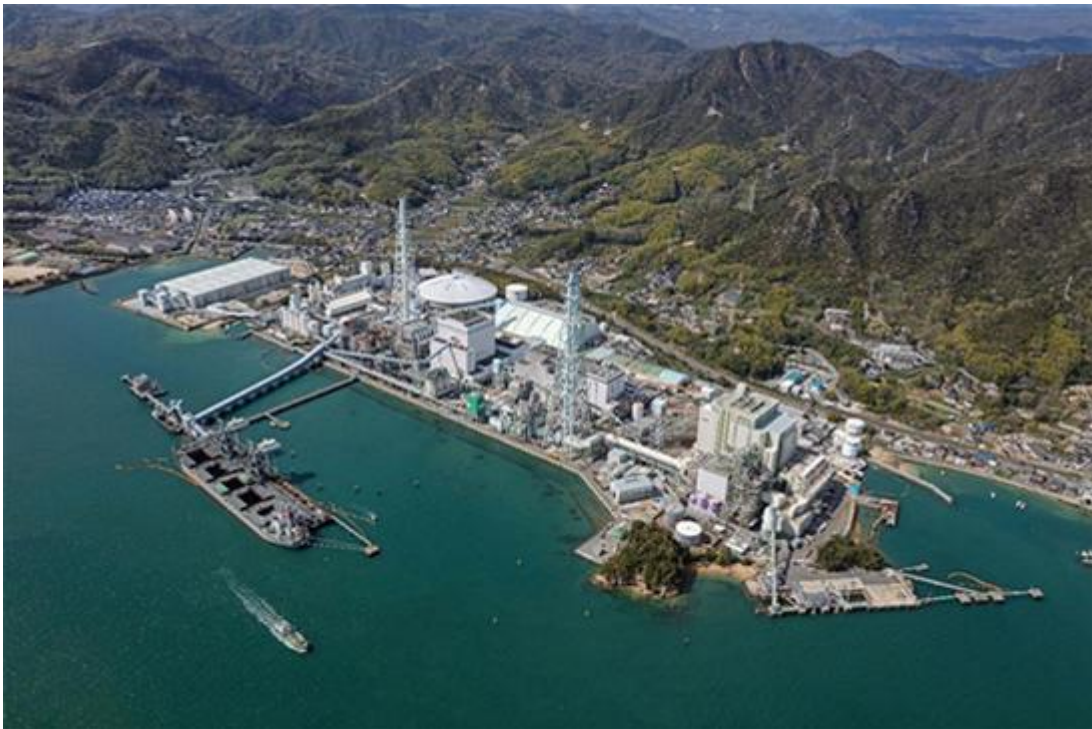
圖 3-1、竹原火力發電廠新 1 號、3 號機組全景
