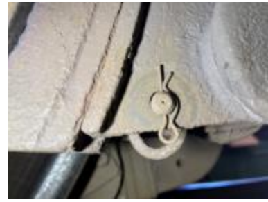
(實際安裝狀況)
