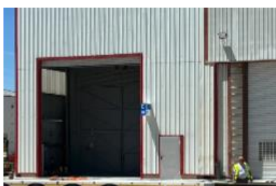
(機具進出門/人員進出門)
