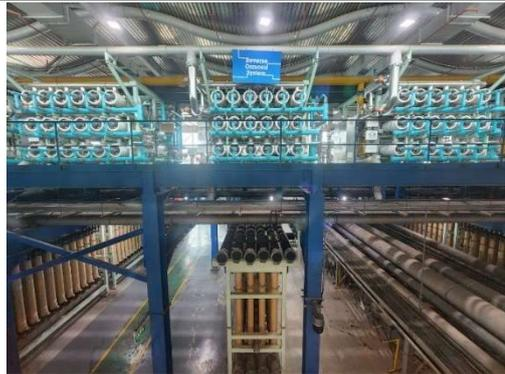
圖 32：新生水廠逆滲透系統實景
