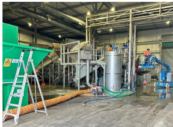
圖3-3 原料處理廠房及設備
