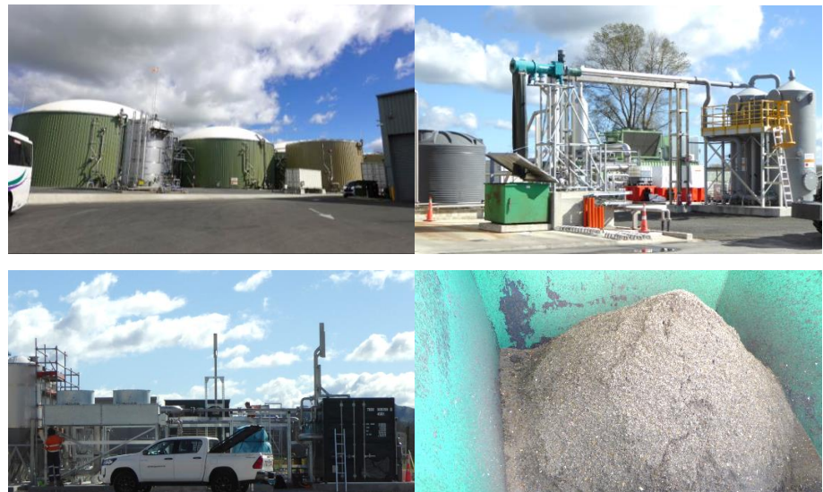
圖3-4 Ecogas 公司之厭氧消化槽(左上)、沼氣純化設施(右上)、沼氣回收及電網設施(左下)、沼渣製成之肥料(右下)
