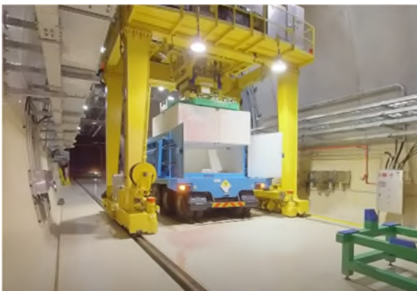
圖 27 橋式起重機吊運照片
