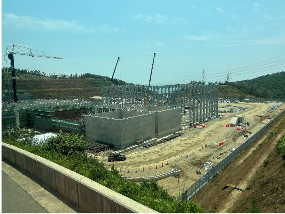
圖29 二期工程之現場參訪照片
