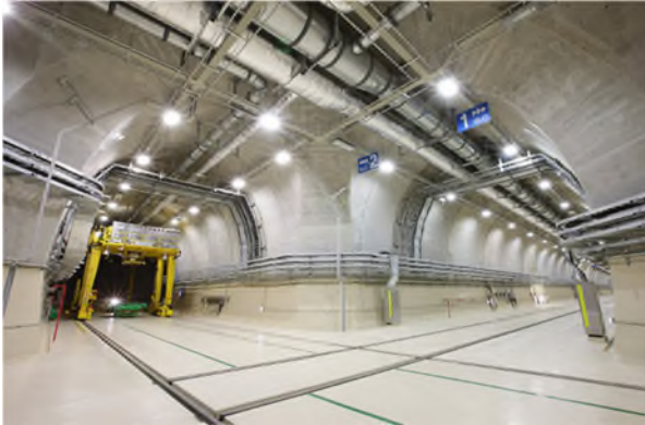
圖 23 橋式起重機及其軌道布設
