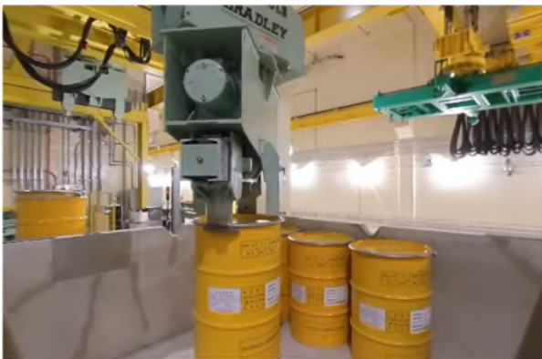
圖 25 廢棄物鋼桶吊至混凝土護箱
