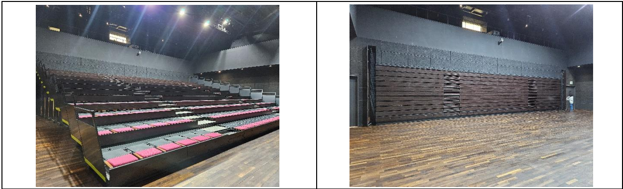
圖：可收納至牆內的活動座位，伸縮僅需約3分鐘即可完成，可依用途快速調整空間設置
