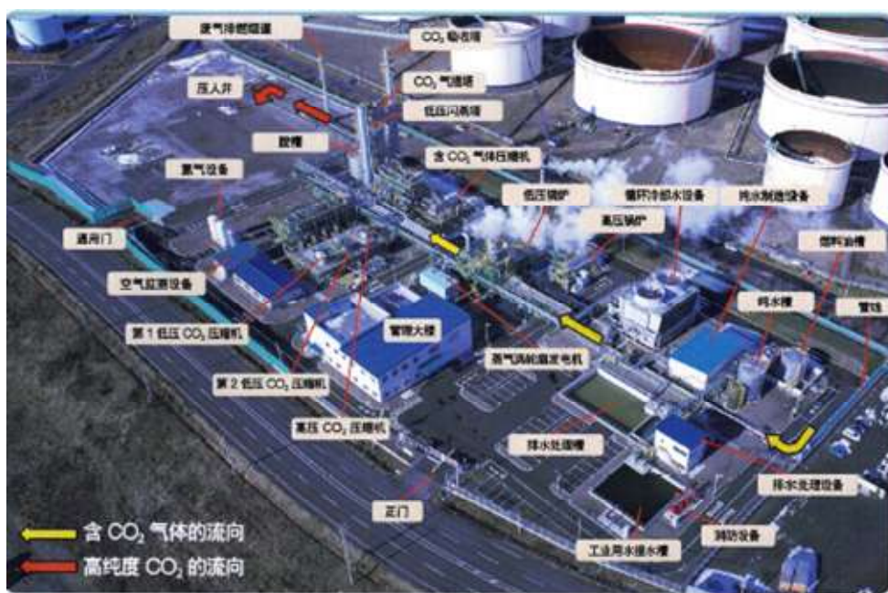
圖 13 苫小牧 CCS 示範工廠全貌
